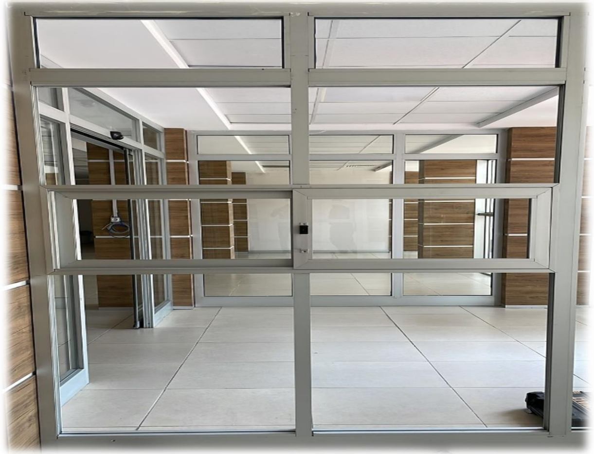
Şekil 5- Mühendislik ve Doğa Bilimleri Fakültesi G Blok Girişinde Bulunan Alüminyum Güvenlik Kulübesi İçin Sürgülü Pencere İmalatı İşi
