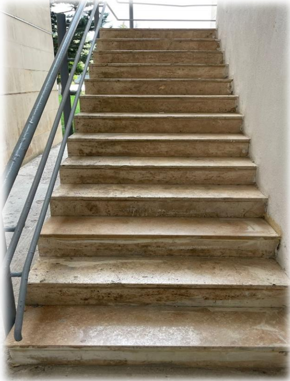
Şekil 7- Rektörlük Hizmet Binası ve Rektörlük Ek Hizmet Binasında Bulunan Merdivenlerden Eski Kaydırmaz Bantlar Sökülmesi Yerine Yeni Kaydırmaz Bant Montajı İşi
