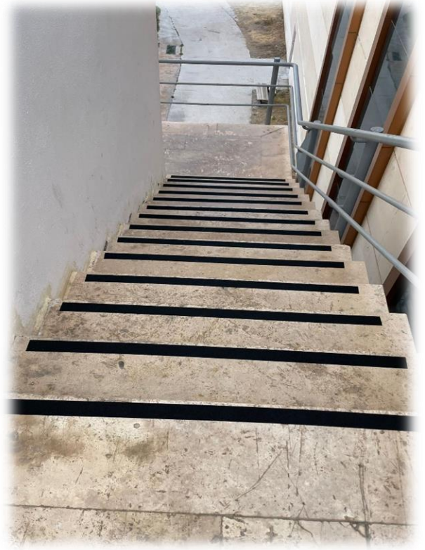
Şekil 7- Rektörlük Hizmet Binası ve Rektörlük Ek Hizmet Binasında Bulunan Merdivenlerden Eski Kaydırmaz Bantlar Sökülmesi Yerine Yeni Kaydırmaz Bant Montajı İşi
