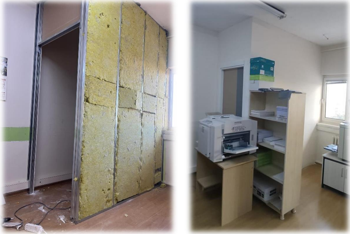
Şekil 10- Gelişim Yerleşkesi Rektörlük Binası Bodrum Kat Depo Bölgesi Duvar Bölme İşi
