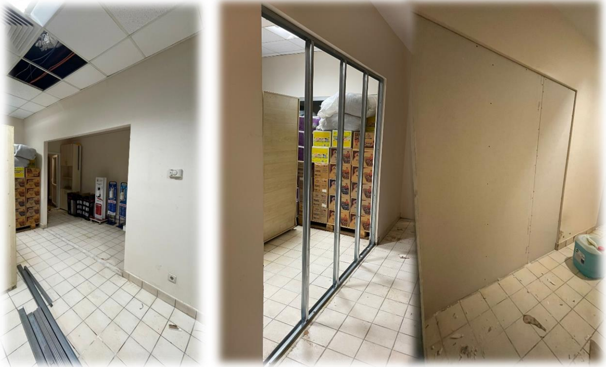
Şekil 10- Gelişim Yerleşkesi Rektörlük Binası Bodrum Kat Depo Bölgesi Duvar Bölme İşi
