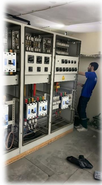
Şekil 3- Mühendislik ve Doğa Bilimleri Fakültesi A Bloкта Bulunan Ana Panonun Değişimi İşi
