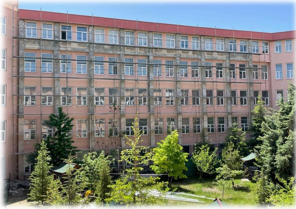
Şekil 4- Mühendislik ve Doğa Bilimleri Fakültesi E ve F Blok İç Bahçesinde Düşme Tehlikesi Bulunan Mermerlerin Sökümü, Sökülen Bölgeye Sıva ve Boya İmalatı İşi
