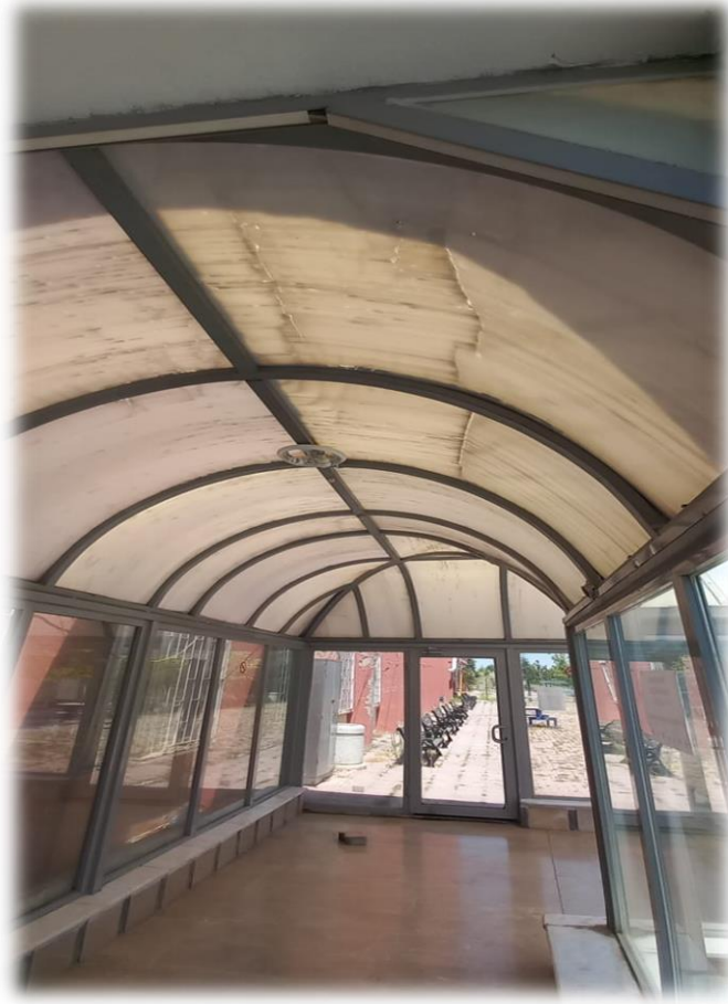
Şekil 8- Teknik Bilimler Meslek Yüksekokulu Binasında Tünel Çatısında Bulunan Eskimiş Polikarbon Çatı Kaplama Malzemesinin Yenilenmesi İşi
