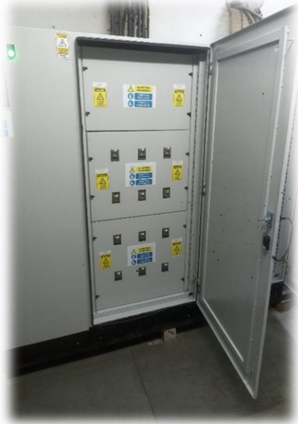
Şekil 3- Mühendislik ve Doğa Bilimleri Fakültesi A Bloкта Bulunan Ana Panonun Değişimi İşi
