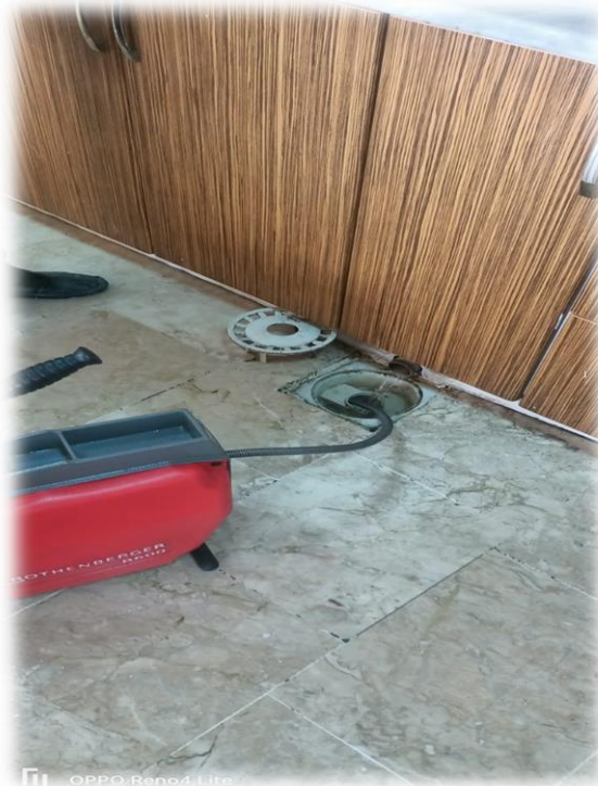
Şekil 12- Konya Teknik Üniversitesine Ait Binalarda Tıkanıklık Bulunan Bölgelerde PVC Tıkanıklık Açılması İmalatı İşi
