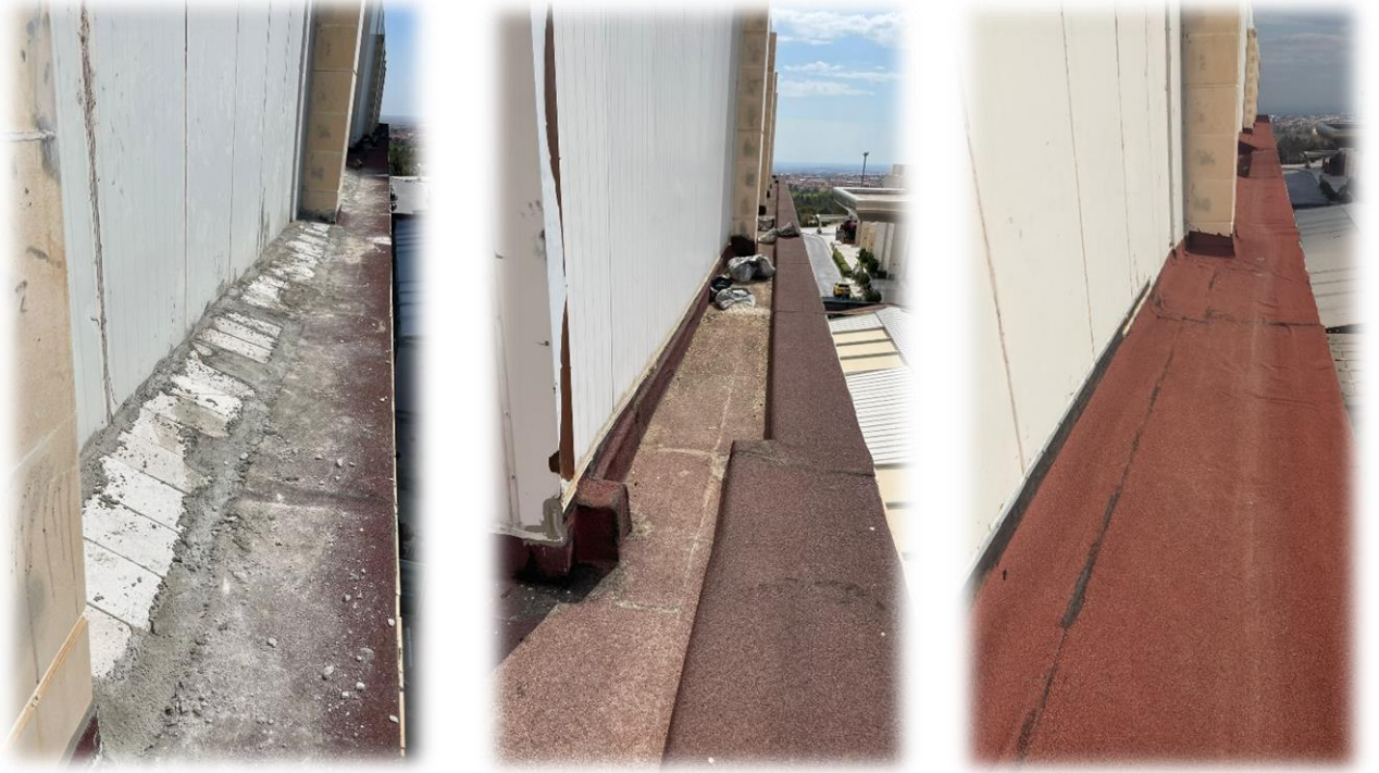
Şekil 11- Rektörlük Hizmet Binası / Mimarlık ve Tasarım Fakültesi Binasında Yemekhane ve Konferans Salonu Akıntıların Kesilmesi Amacı İle Boşlukların Gaz Beton İle Doldurulması, Üzerine Şap Atılması ve Çift Kat Membran İmalatı İşi
