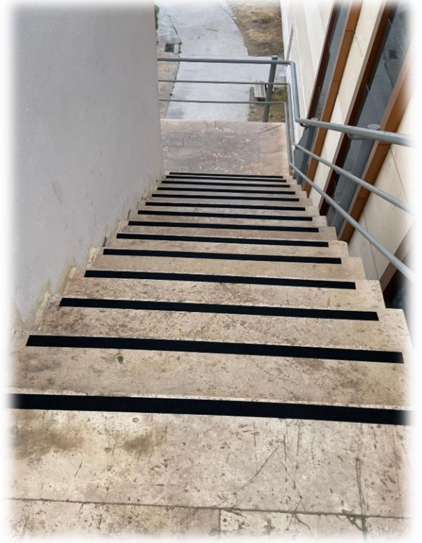
Şekil 7- Rektörlük Hizmet Binası ve Rektörlük Ek Hizmet Binasında Bulunan Merdivenlerden Eskiymiş Kaydırmaz Bantlar Sökülmesi Yerine Yeni Kaydırmaz Bant Montajı İşi
