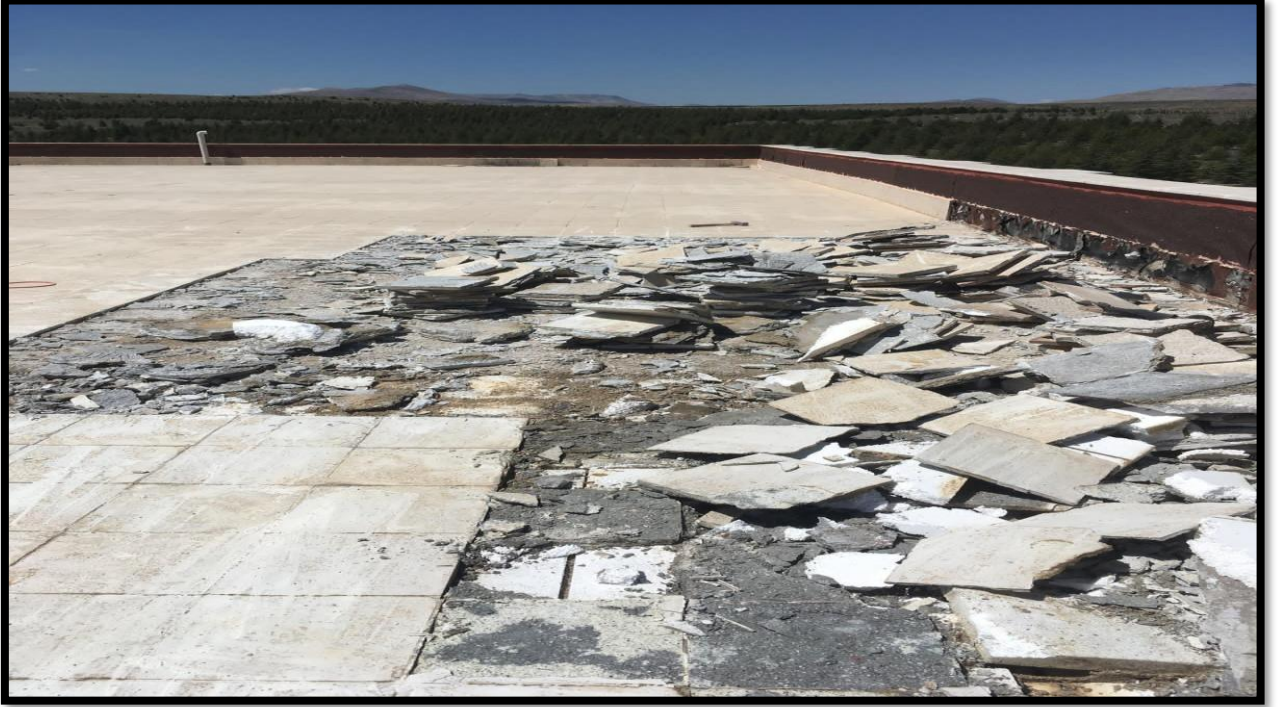
Şekil 7- Teknik Bilimler Meslek Yüksekokulu E Blok Çatısı Bitümlü Membran Kaplama Yapım İşi
