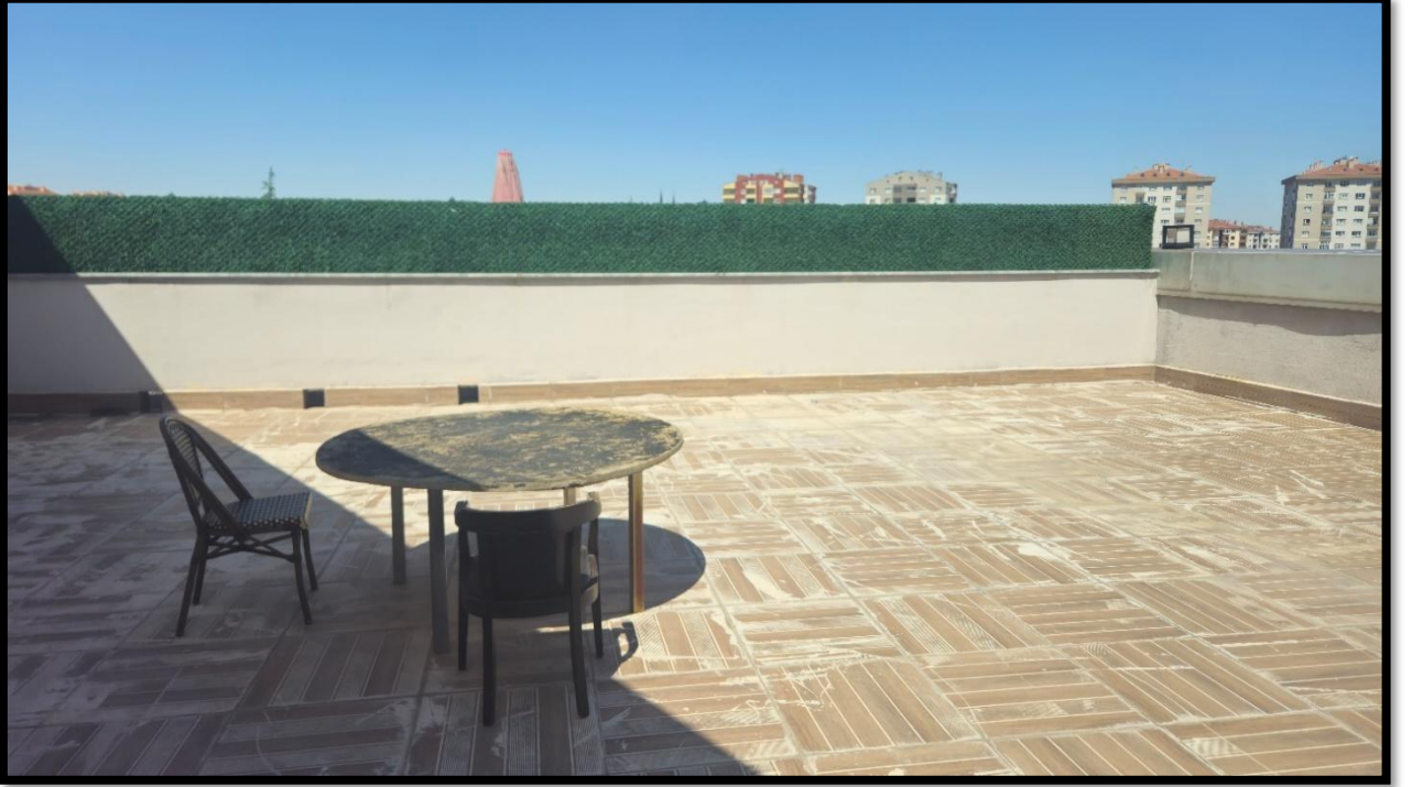
Şekil 9-Rektörlük Hizmet Binası Misafirhane Terası Bitümlü Membran Kaplama Yapım İşi
