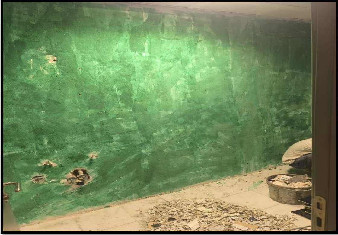
Şekil 8- Mimarlık ve Tasarım Fakültesi WC'lerinde Fayans Tadilat İşi
