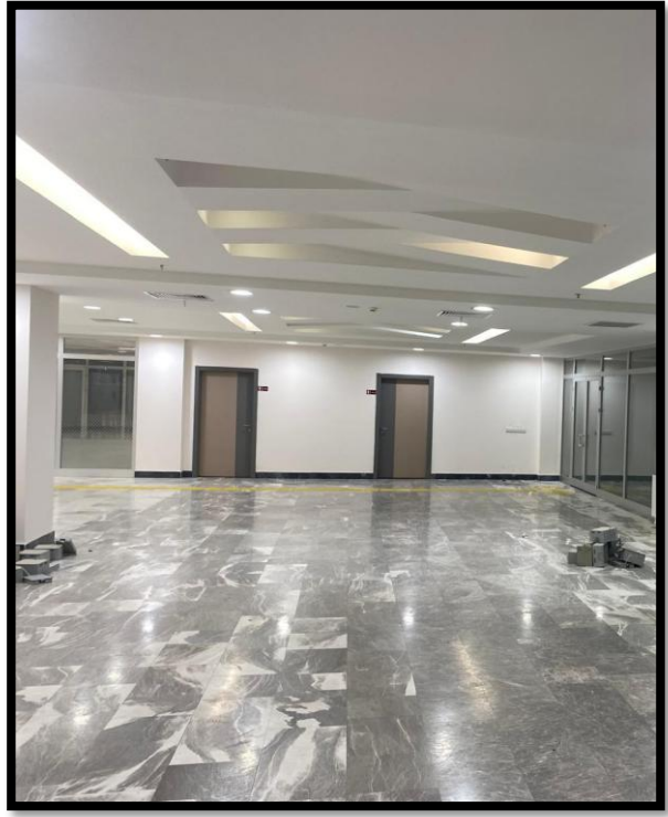
Şekil 12- Rektörlük Hizmet Binasında Kare Aydınlatmaların Değişimi Yapılması İşi
