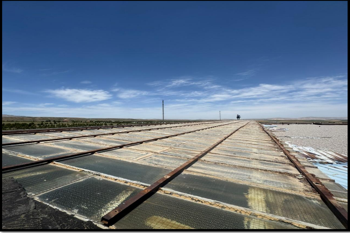
Şekil 5- Teknik Bilimler Meslek Yüksekokulu Derslik Çatısı Polikarbon Kaplama İşi
