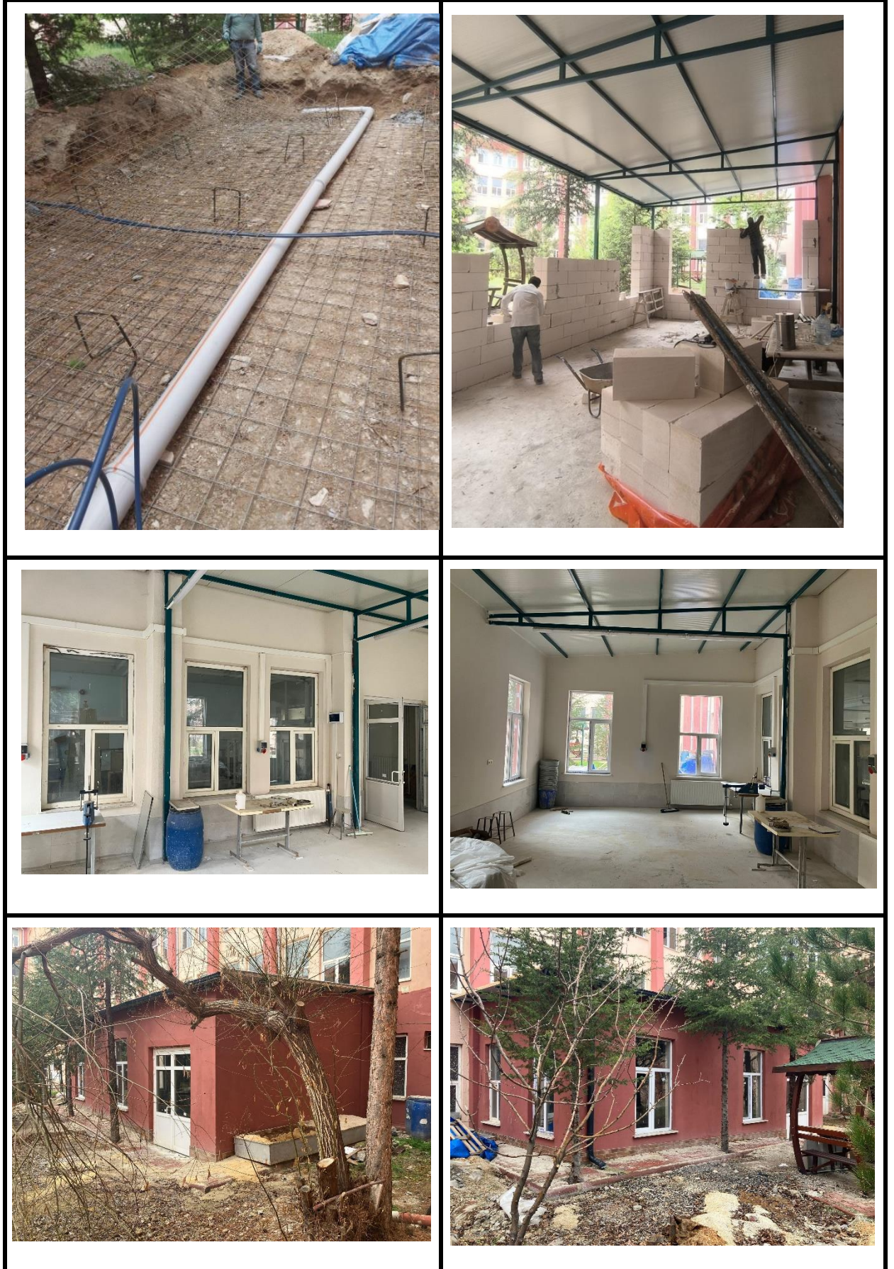
Şekil 3- 2024 Yılı Mühendislik ve Doğa Bilimleri Fakültesi E Blok iç bahçeye Geoteknik Laboratuvarı ve pis su ve temiz su altyapı tesisat imalatları.
