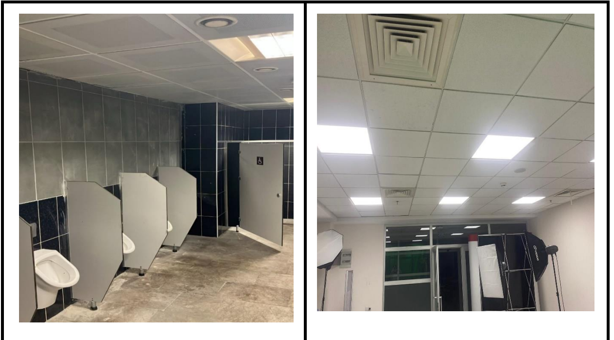
Şekil 13- 2024 Yılı Konya Teknik Üniversitesi binalarında seramik ve asma tavan tadilatları.
