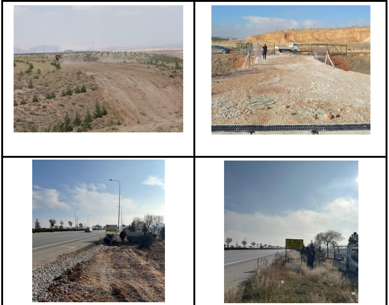
Şekil 9- Konya Teknik Üniversitesi ana yerleşke projelendirme çalışmaları sonrasında ring hattı boyunca kazı ve dolgu işlemleri yapılarak ana yoldan proje sahasına girişi güzergâh çalışmaları.
