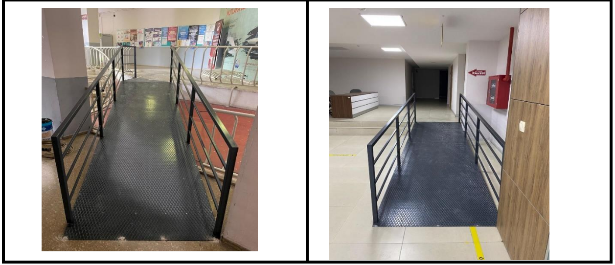
Şekil 17- 2024 Yılı Mühendislik ve Doğa Bilimleri Fakültesi kantinine erişim sağlamak üzere merdiven tipi engelli platformu imalatı.
