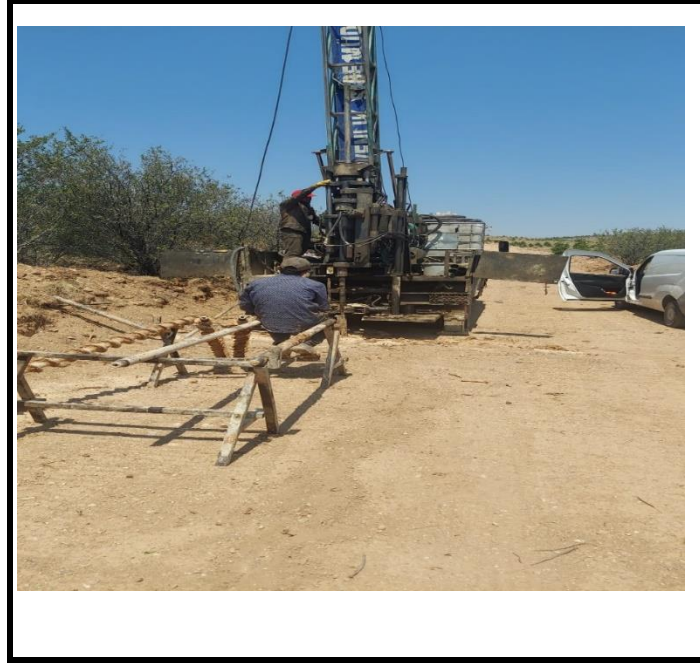
Şekil 8- Konya Teknik Üniversitesi ana yerleşke yol ve alt yapı zemin etüdü çalışmaları.
