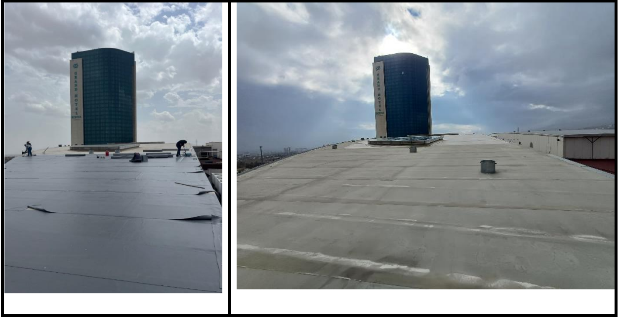
Şekil 4- 2024 Yılı Rektörlük Hizmet Binası çatısında PVC membran imalatı.
