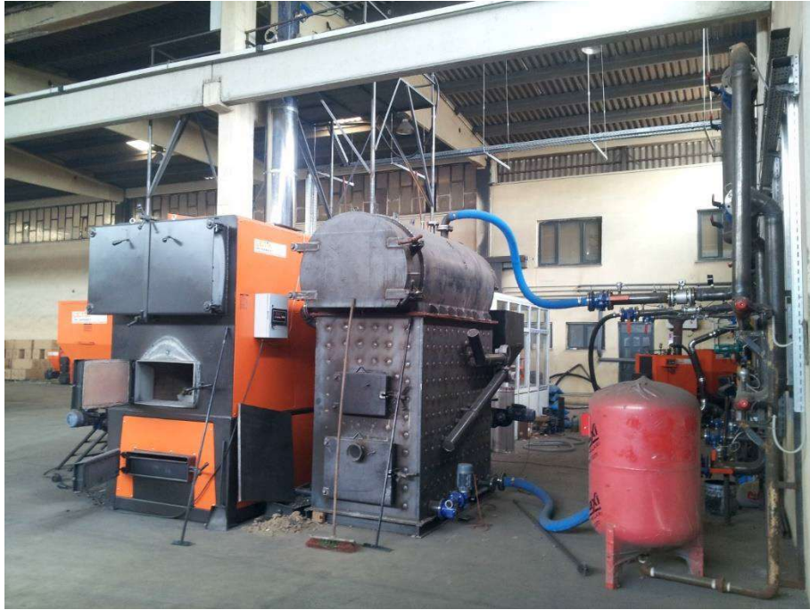
Şekil 22. Tam otomatik yüksek performanslı hareketli ızgaralı kazan
