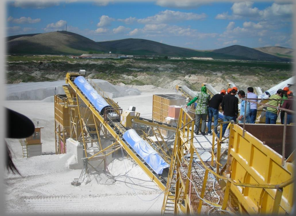
Kırma taş ocağı gezisi (2010)
