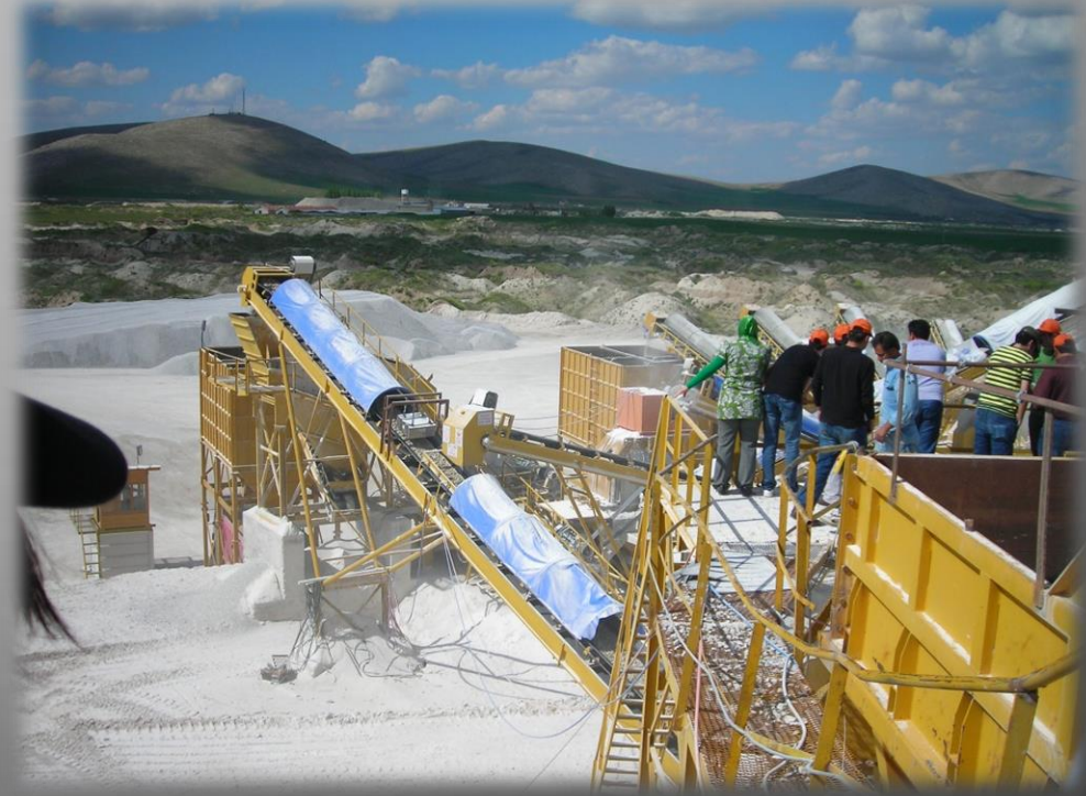
Kırma taş ocağı gezisi (2010)
